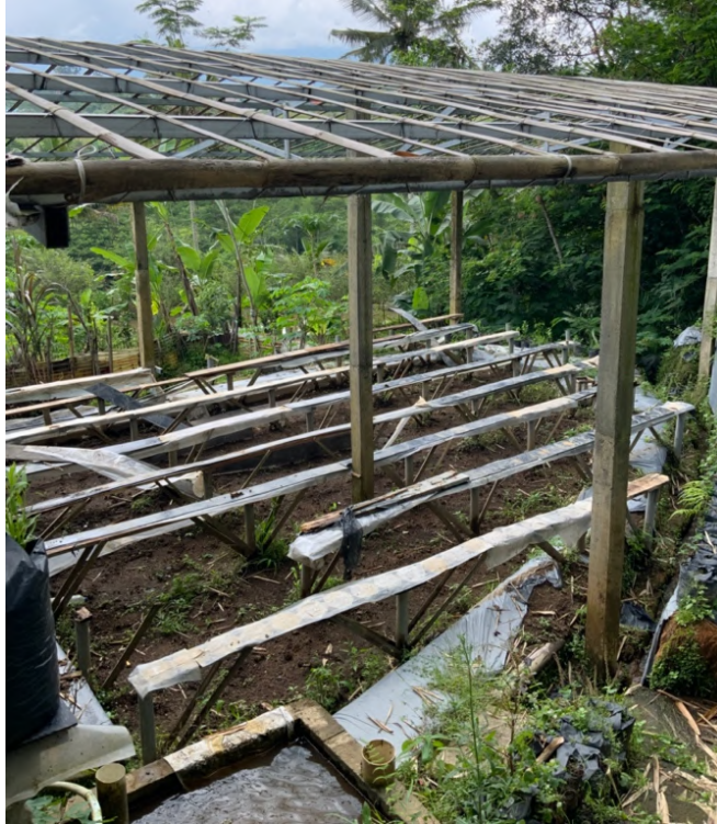
Gambar 11 Kebun dalam tahap perawatan dan renovasi (Sumber : dokumen pribadi)
