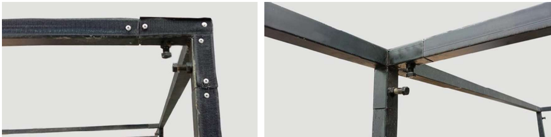
Gambar. Pemasangan sudut dan sambungan rangka booth
